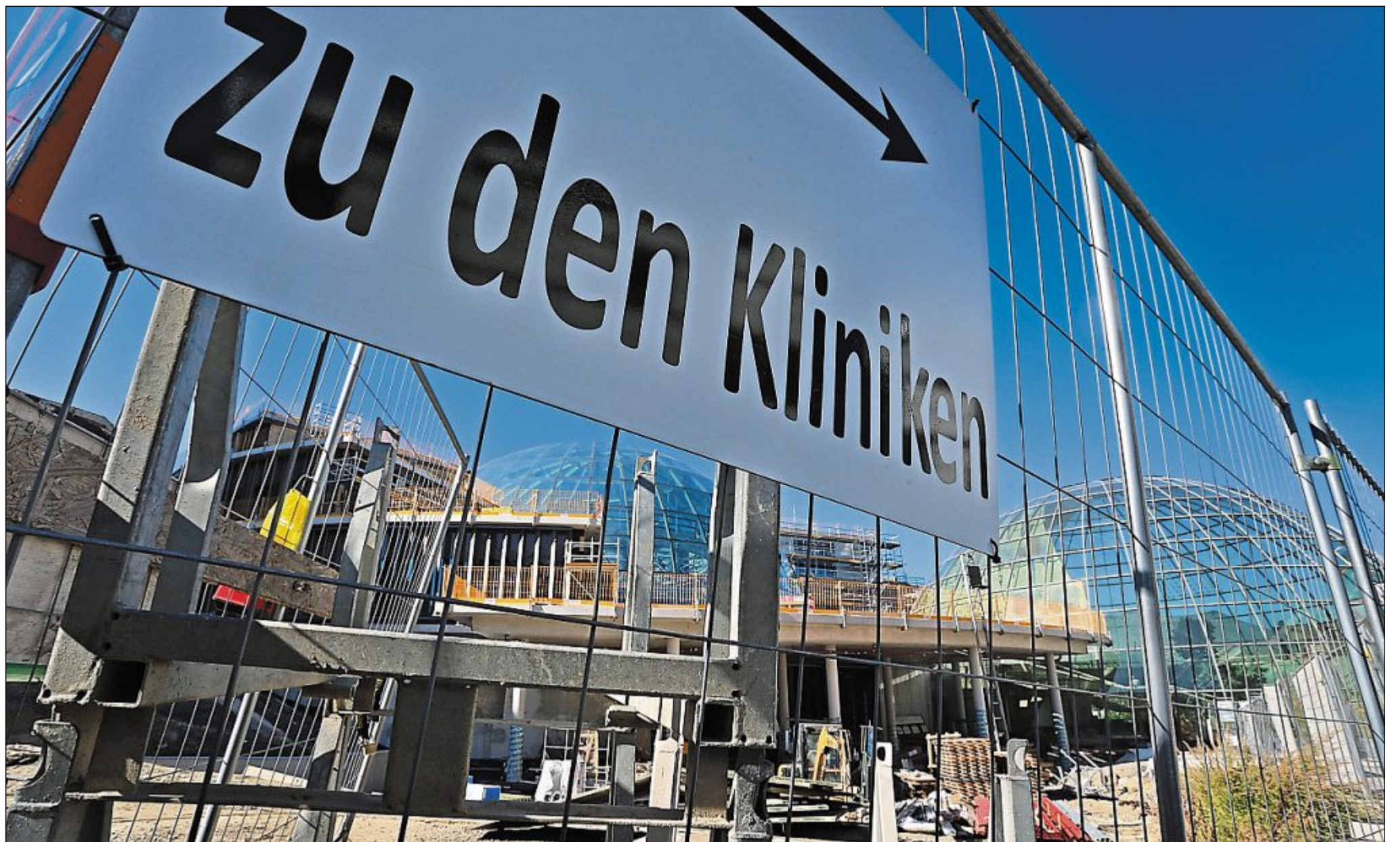
Um die Vergabe der Installation von Sanitäreinrichtungen im Rahmen der energetischen Sanierung eines Krankenhauses gab es Streit.
